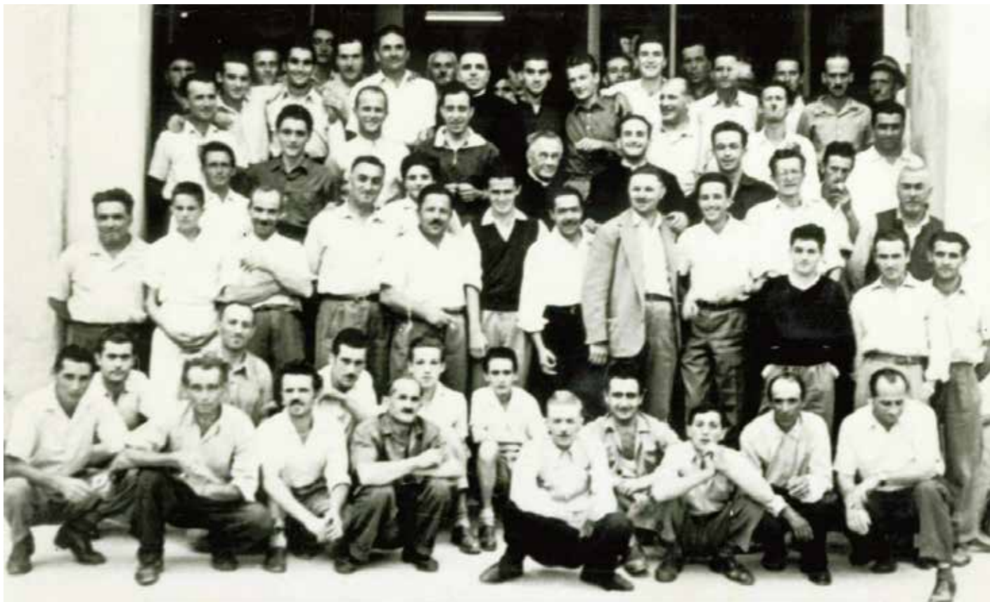
Nelle tre foto: Tutti gli operai della ditta Serenari Assuero che hanno lavorato, in posa e durante la bandiga.
