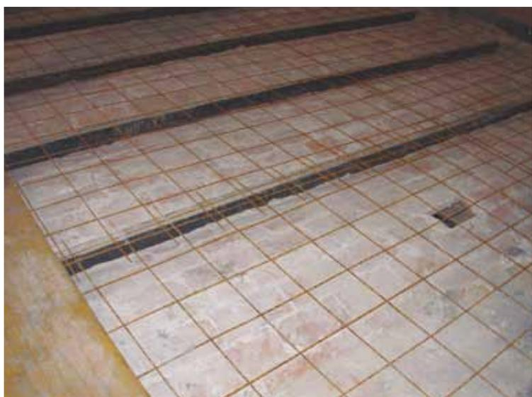
*In alto: il solaio del pavimento della cappella laterale viene rifatto completamente, con opere di rinforzo. Uguale trattamento ha ricevuto il pavimento della navata centrale.*
