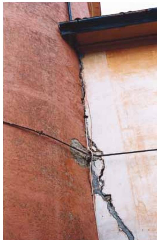
*Si posizionano i ponteggi per le opere di restauro e rinforzamento delle parti esterne e del tetto. A lato: particolare di una profonda lesione tra l'abside e la canonica.*
