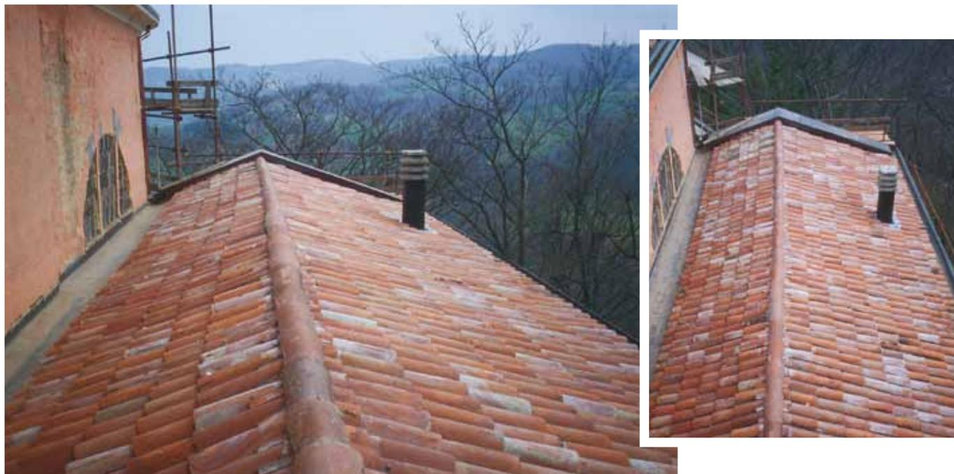
*Il tetto della chiesa, dalla adiacente canonica e delle cappelle laterali sono stati rinforzati e la copertura completamente riposizionata.*
