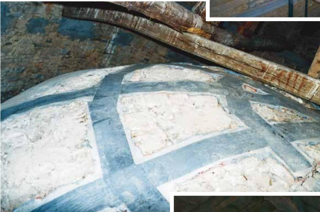
*Per il consolidamento della cupola, che minacciava di crollare, sono state utilizzate fasce di rinforzo in fibre di carbonio: una tecnologia assai sofisticata usata anche nella basilica superiore di Assisi, che pure ha subito gravi danni a causa del terremoto del 1997.*
